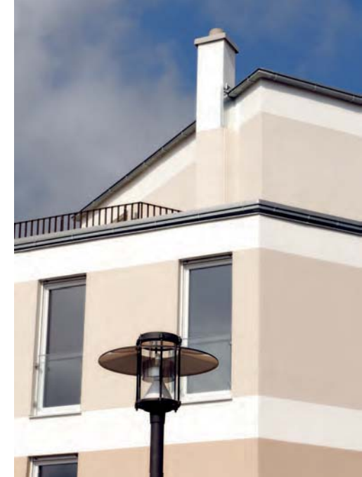
Vollwärmeschutz sorgt für Einsparung von Energiekosten
