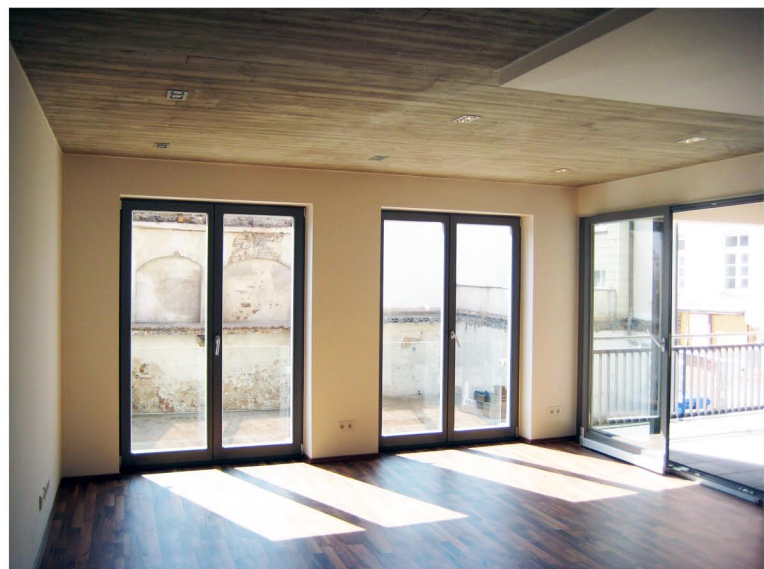
WOHNUNG IN HAUS 4 MIT DECKE IN BRETTSCHÜSSUNG
