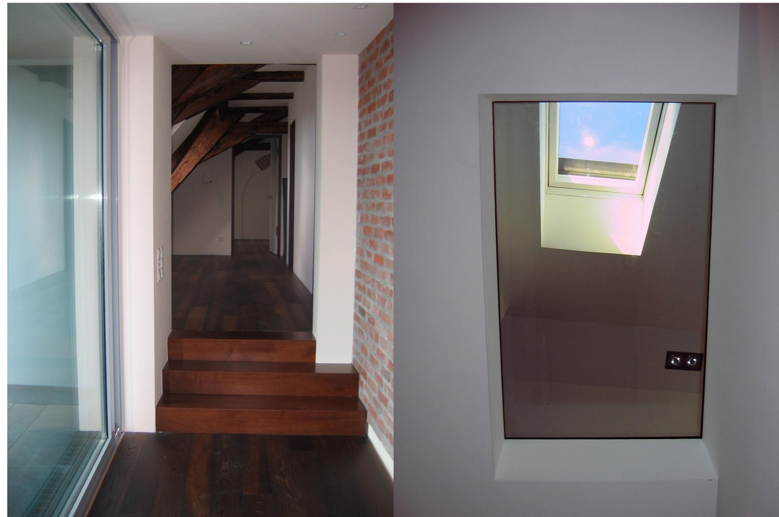
HISTORISCHER DACHSTUHL IN MAISONETTE-WOHNUNG HAUS 6+8
