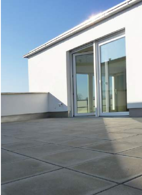
Vollwärmeschutz sorgt für Einsparung von Energiekosten
